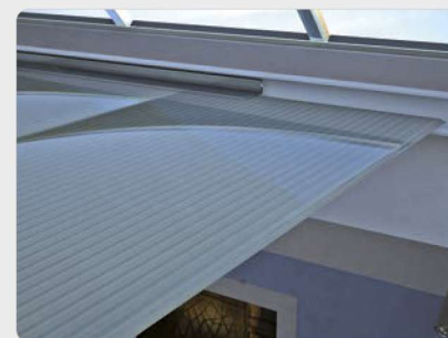
FALSOS TECHOS Ejecución de falsos techos continuos transparentes, mediante encastre de los elementos
